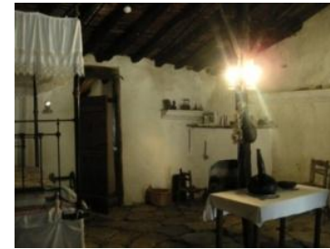
χρήση πέτρας στη βάση της τοιχοποιίας, πλιθαριού στο πάνω μέρος της οικοδομής (αριστερά και πάνω δεξιά) και γύψινο επίχρισμα στο εσωτερικό
