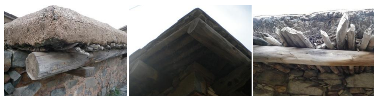
λεπτομέρειες απολήξεων οροφής (κροδώματα)
