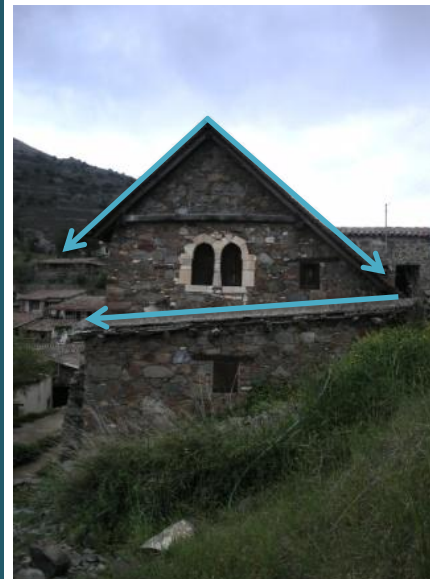
μονοκλινείς και δικλινείς στέγες για μεταφορά βρόχινου νερού στο έδαφος
