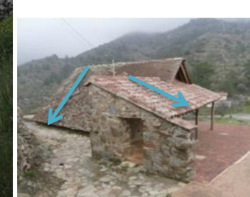
μονοκλινείς και δικλινείς στέγες για μεταφορά βρόχινου νερού στο έδαφος
