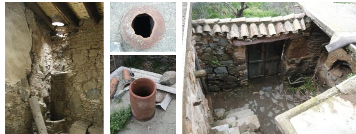
άνοιγμα οροφής για δροσισμό και φωτισμό του χώρου
