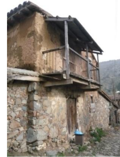
χρήση πέτρας στη βάση της τοιχοποιίας, πλιθαριού στο πάνω μέρος της οικοδομής (αριστερά και πάνω δεξιά) και γύψινο επίχρισμα στο εσωτερικό
