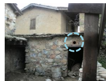
χρήση αρσέρων στο πάνω τμήμα της τοιχοποιίας για έξοδο θερμού αέρα και δροσισμό χώρου
