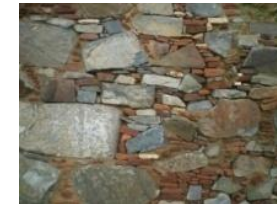
ντόπια δομικά υλικά – πέτρα , πλιθάρι
